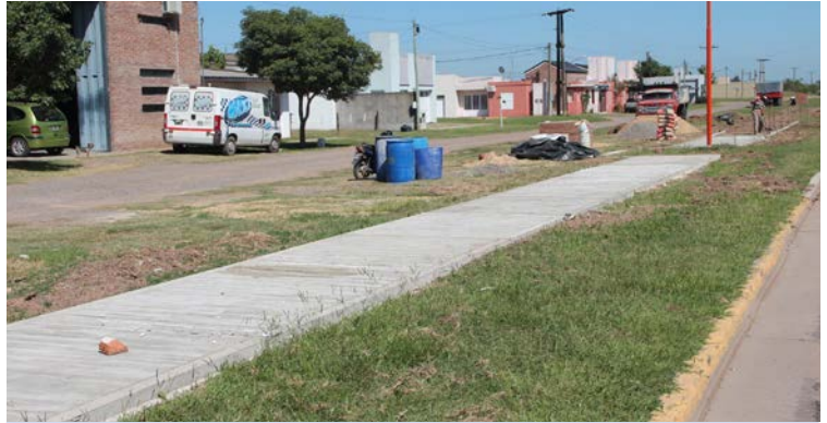
Mejoras en el ingreso oeste a la localidad.
