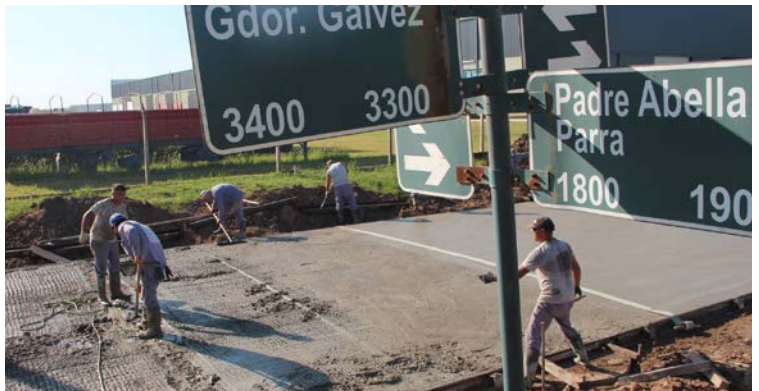
Iniciamos el asfaltado de calles de la zona norte.
